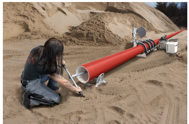
Wulstentfernung mit dem HÜRNER Innenwulstentferner 300
